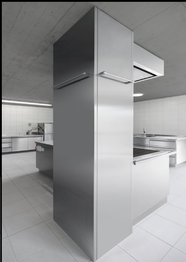
Sloup kompletně obložený nerezovou ocelí
