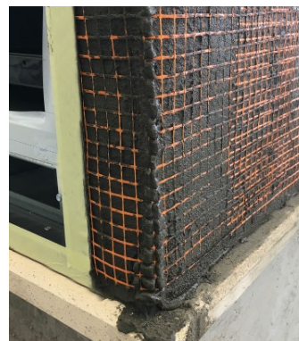
Malta s armovací sítí
