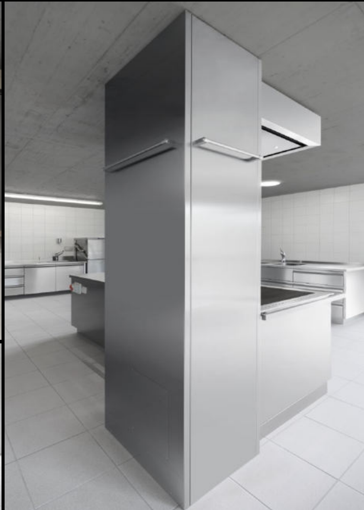
Sloup kompletně obložený nerezovou ocelí
