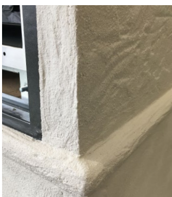
Dokončení s ušlechtilou omítkou
